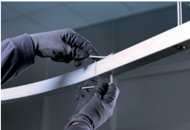
und ziehen die Schrauben M6 gut an, um eine solide Isolation zu erreichen. Diese Aktion wird für die ganze Leitung wiederholt.
