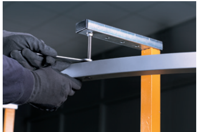
Der nächste Schritt ist die Ausrichtung der Höhe an die Leitung, ein Vorgang, bei dem wir diese Höhe regulieren mit den Schraubenmutter M10 des Trägers. Wenn das ganze System einmal die richtige Höhe hat, drehen wir die Schraubenmuttern definitiv an, die sich an den Trägern befinden.
