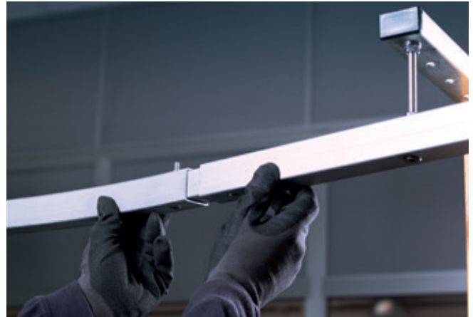
Wir verbinden die Profile mit den Stossstangen,
